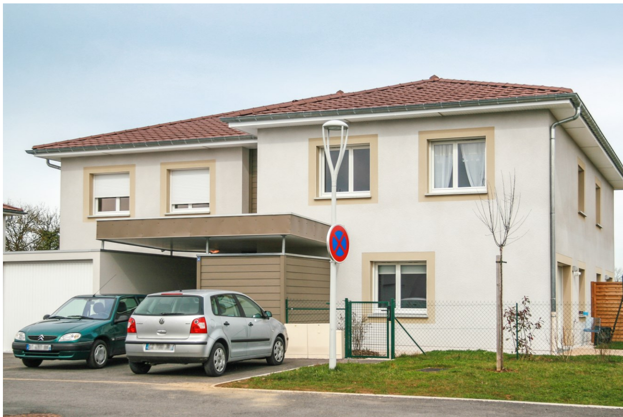
Opération près du collège, Saint-Vit Auteur : Habitat 25
