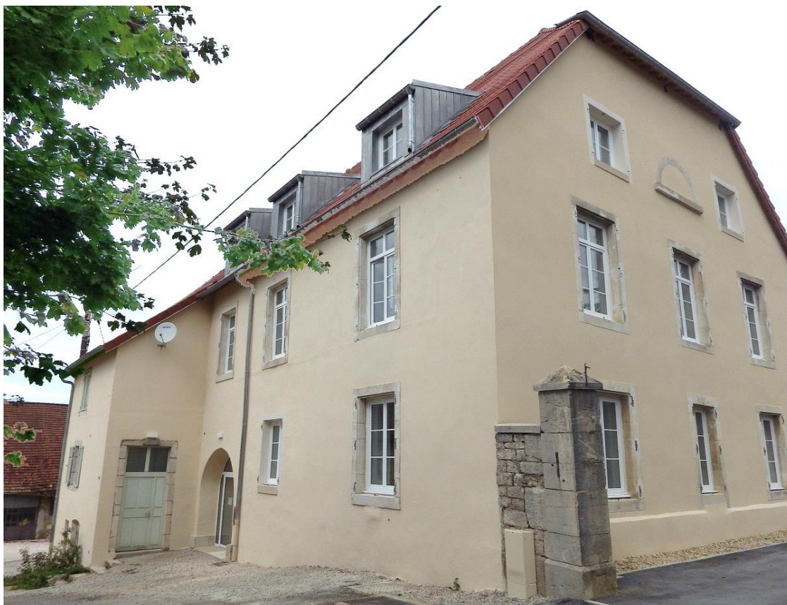
Le Presbytère après travaux de réhabilitation, Dannemarie-sur-Crète Auteur : Grand Besançon Habitat
