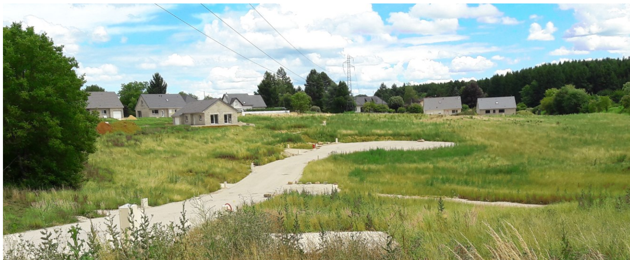
Les travaux d'aménagement en cours, lotissement des Hironnelles, Pirey Auteur : AudaB
